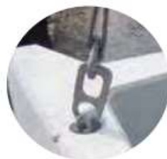
カップラー取付部の拡大写真
